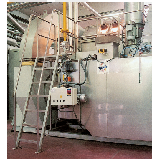
Veduta del gruppo di filtraggio, riscaldamento e ventilatore di mandata dell'aria.
