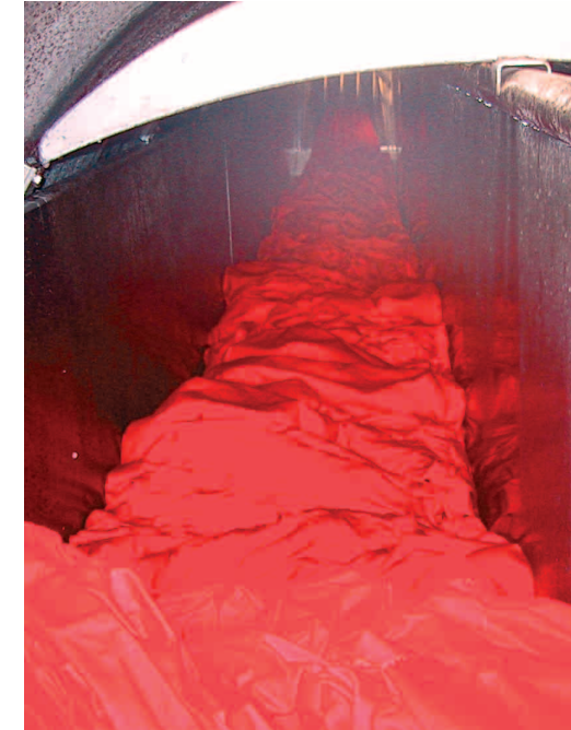
Tessuto disposto in falda sul condotto.
