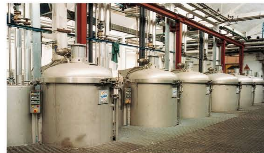
Veduta parziale di un impianto tintura tops a impacco con portamateriali centrifugabili
