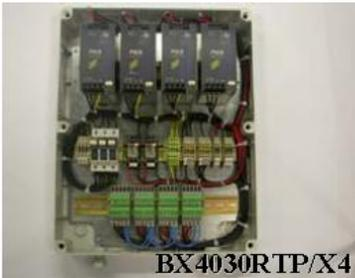
Anschlussbox komplett mit 4 stabilisierten Netzteilen PSU20ASM mit Kabeln für den Anschluss an Strickmaschinen mit Anschlüssen für KTF/FLAT Flachkabel
